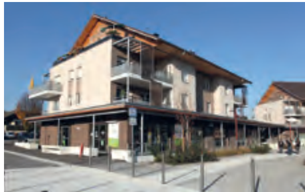
Albens - Immeuble locatif et commerces
