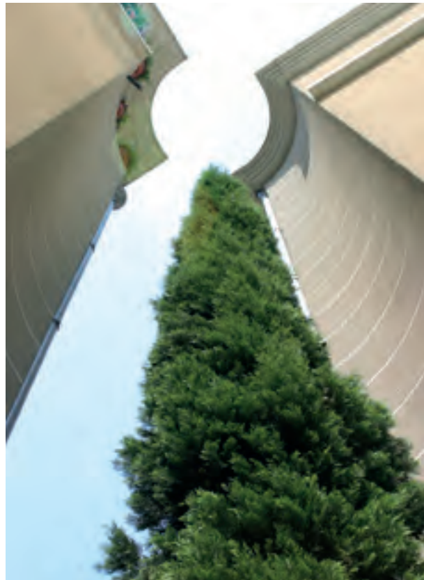
Oullins - Logement locatif
