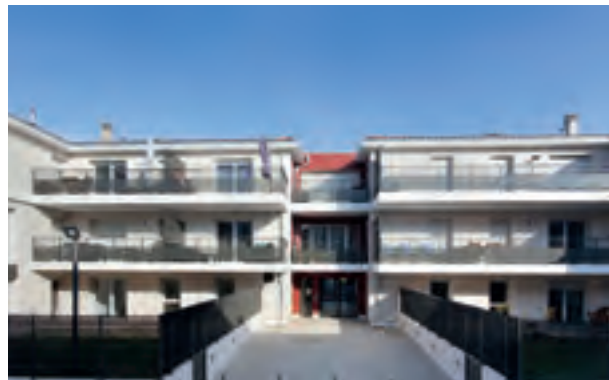
Lentilly - Immeuble locatif
